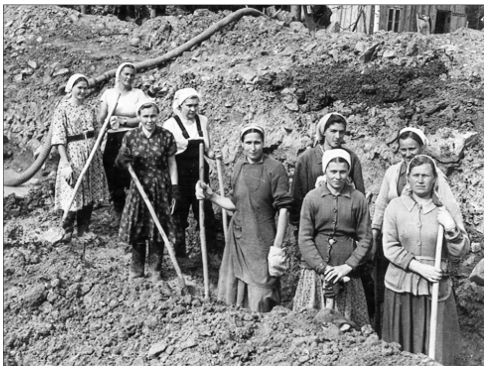
Бригада на зачистке траншеи фундамента на строительстве дома в 4 м-не. Быть может, кто-то себя узнает?..
